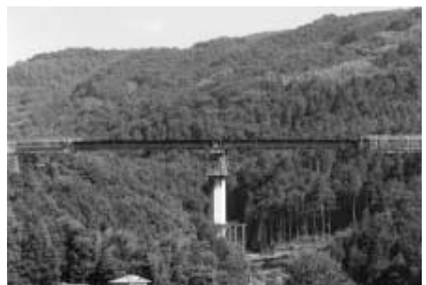
Photo .14 回転完了
