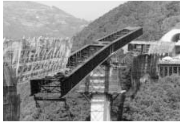
Photo .11 施工状況（回転状況）
