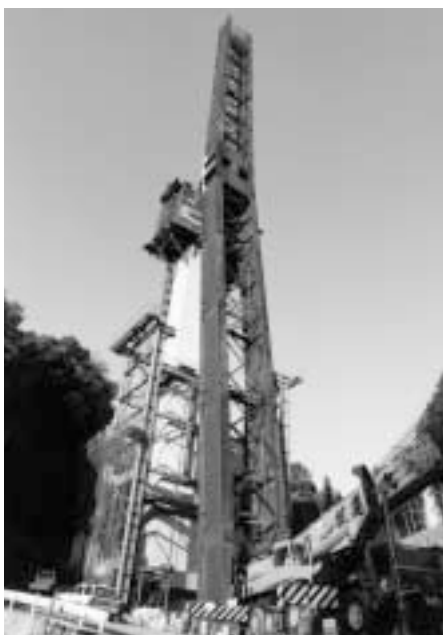
Photo .10 施工状況ジャッキアップ完了
